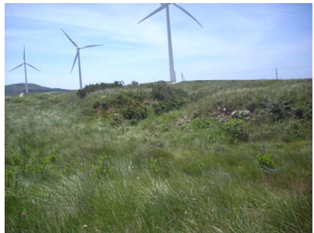
Figura 2 – Vista Geral (Sul)
