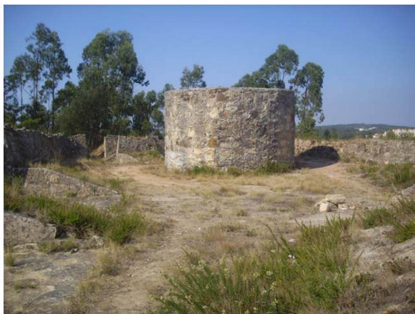
Figura 2 – Vista Geral (Norte)
