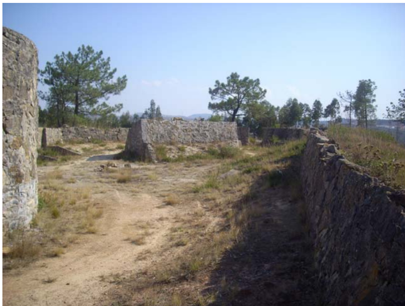
Figura 1 – Vista Geral (Sul)
