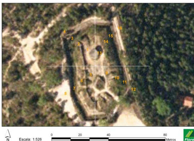
Fortes das Linhas de Torres - Forte dos Olheiros - Reduto nº 23 Parcelas de Ocupação
